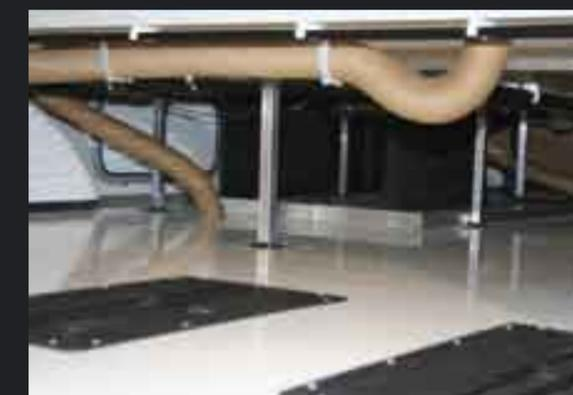
Dans le double plancher, les conduites d'alimentation sont protégées contre le gel en hiver.
